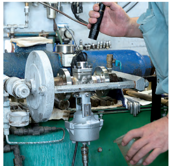
写真3 バルブ検査作業
